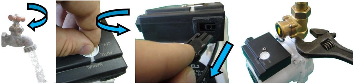
Primeiramente fechar o ponto de alimentação de água e desligar o pressurizador, para evitar acidentes.
